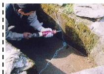
水路のひび割れ補修
