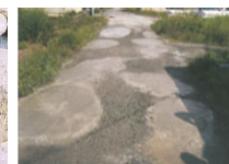
農道の窪みの補修
