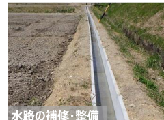
水路の補修・整備
