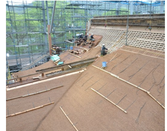
<建造物維持修理の様子>
