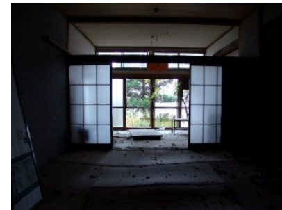
老朽化したホテル・旅館の改修
